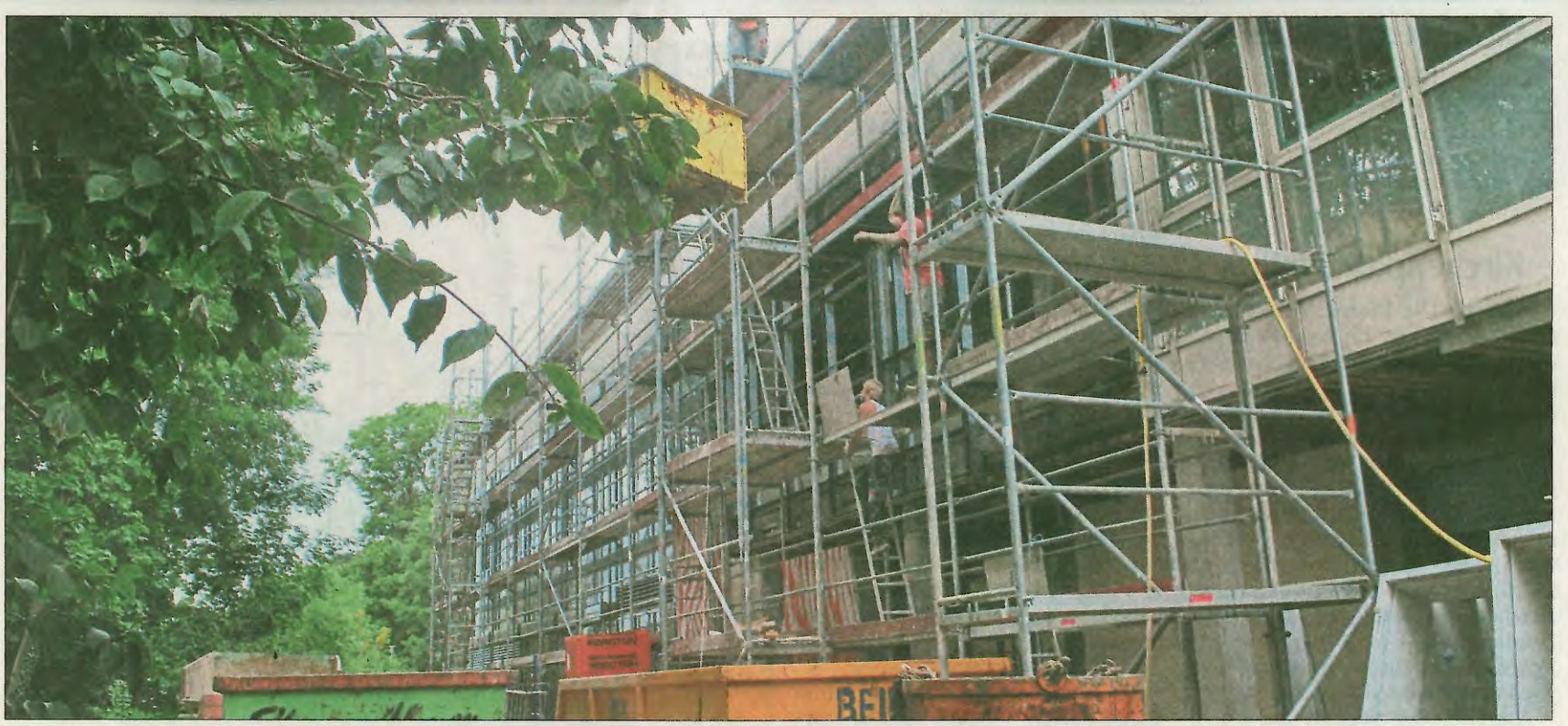
Verschiebungen im Zeitplan: Die Bauarbeiten an und in der Kreisklinik werden noch einige Monate in Anspruch nehmen. Die „Ertüchtigung“ des Hauses, die 18,7 Millionen Euro kostet, wird im Frühjahr ihren Abschluss finden. (Fotos: Raith)
