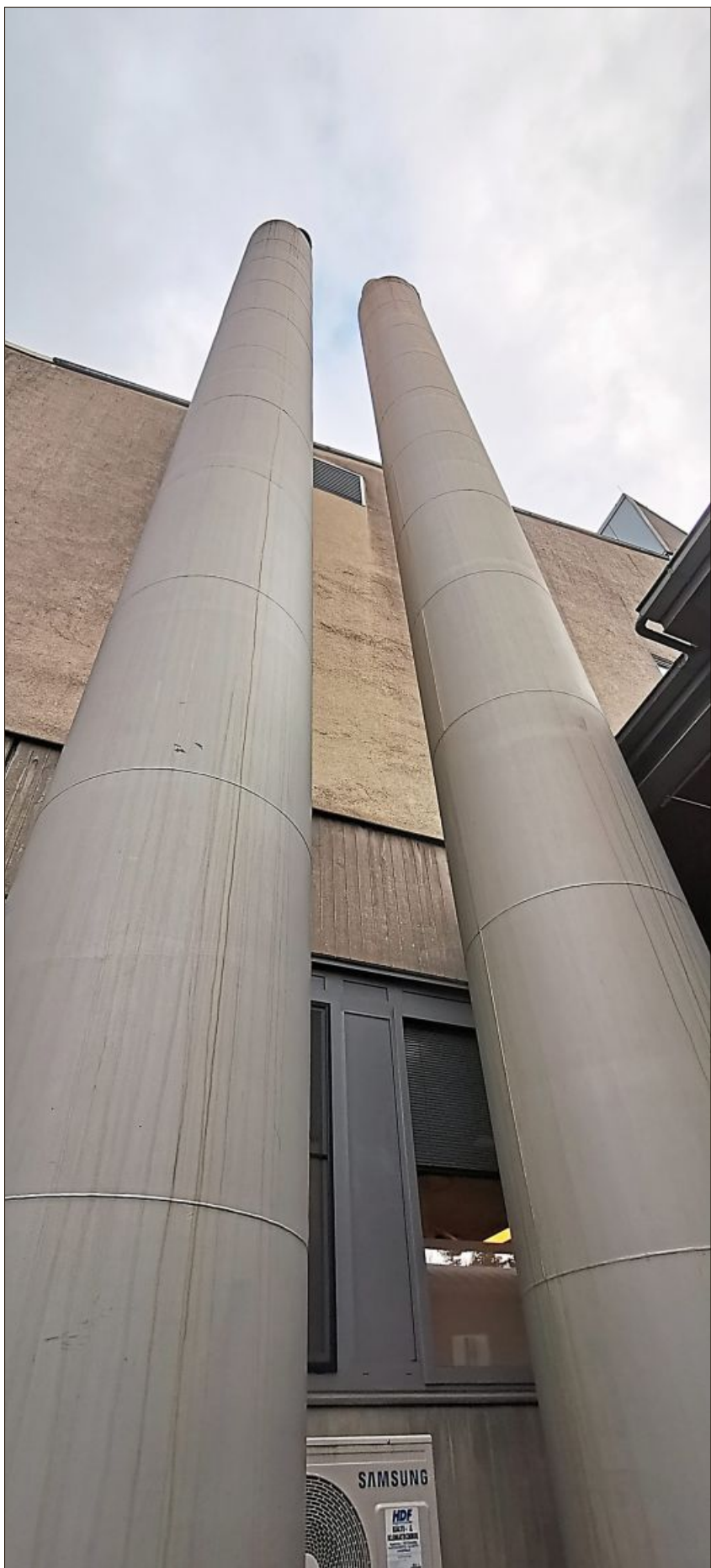
Die Energiekosten für die Kreisklinik Wörth – hier die Kamine – erreichen mittlerweile luftige Höhen.
