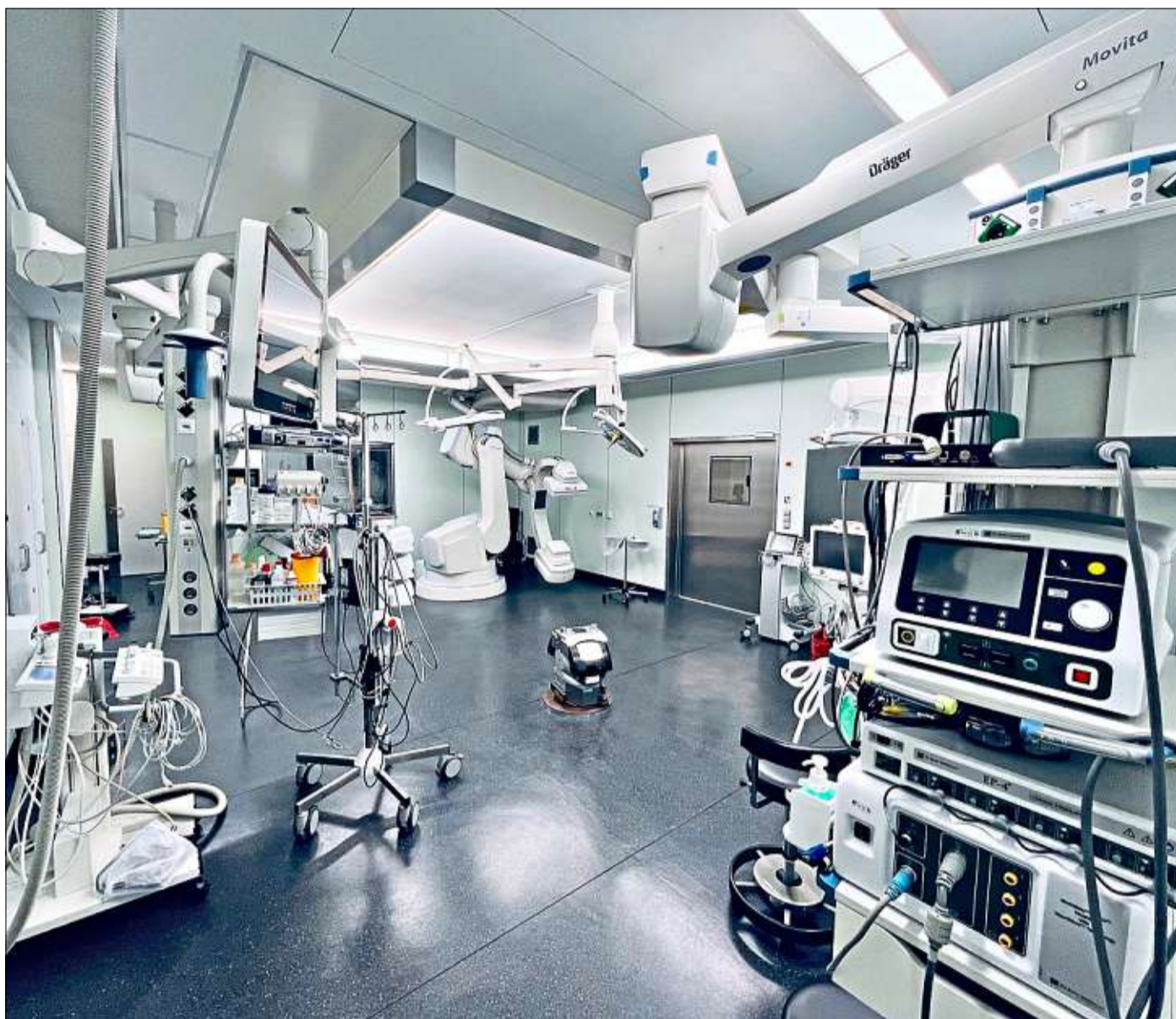
Einer der neuen Hybrid-OPs in der Kreisklinik: In diesen hoch-technologisch ausgestatteten Operationssälen ist es für Chirurgen beispielsweise möglich, ohne größere Operationswunden zu arbeiten. Foto: Stefan Hundt
